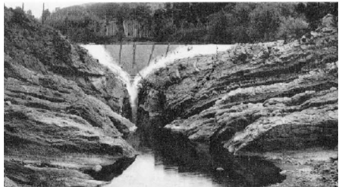
Imatge històrica de la presa del Cairat
