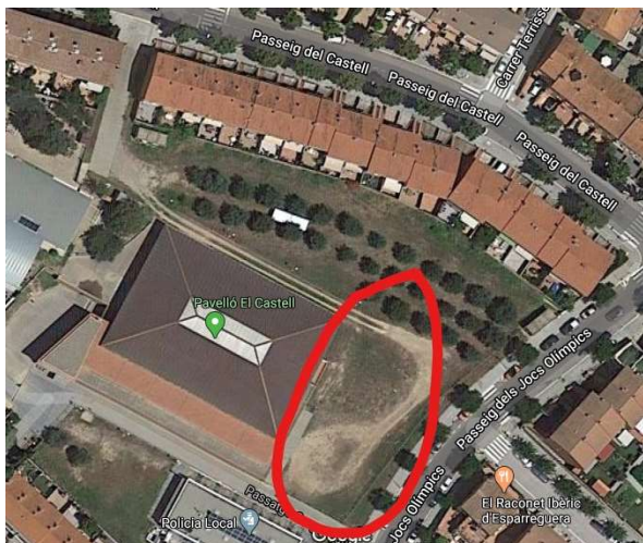
Zona exterior del poliesportiu
